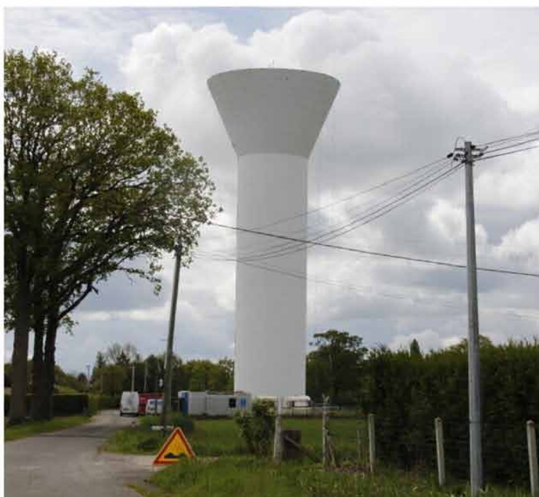
Les travaux sur les châteaux d'eau doivent durer jusqu'à la fin de l'année. Celui de Chamblac est actuellement en rénovation. ©Lina Tran
